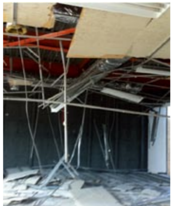
以前のRDVシステムズの社屋。2階の全面ガラスが完全に割れ、室内は天井崩れ落ち、床もめくれ上がるという惨状だった。目の前にある山が揺れたのだと言う。
